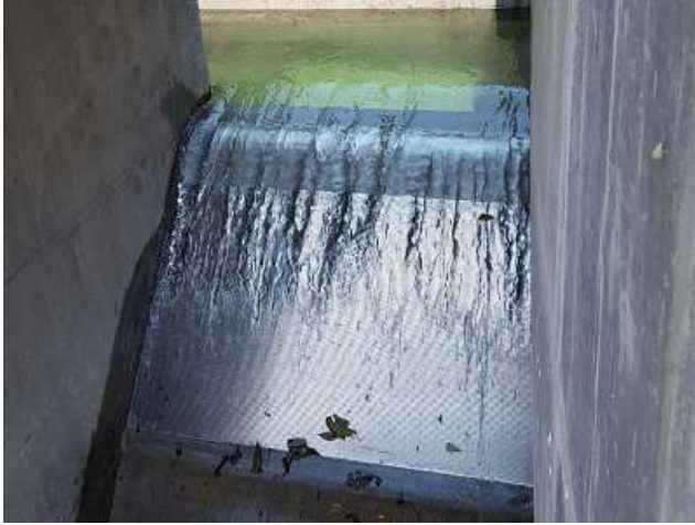
【取水量 320ℓ/秒、幅 1.9m、傾斜距離 1.1m】
