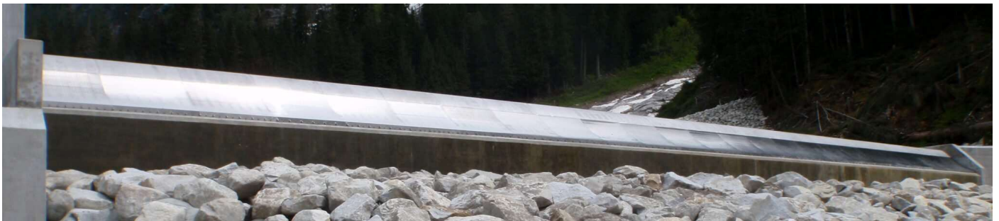
カナダで稼働中のコアンダ スクリーン 長さ 61m、傾斜距離 1.8m、取水量 26.5ton/秒
